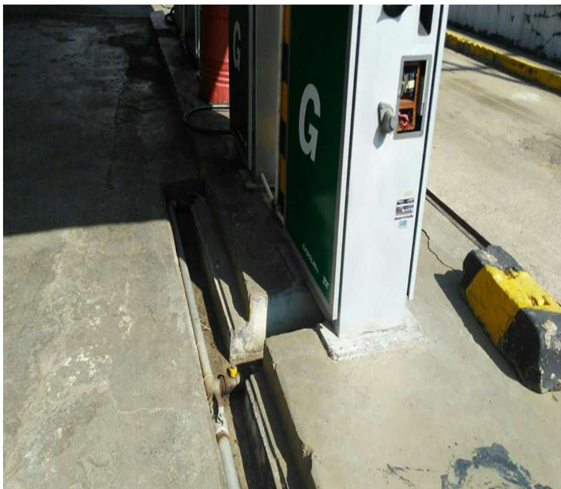
Figura 3: Canaletas ao redor da área de abastecimento no posto da AMAN
