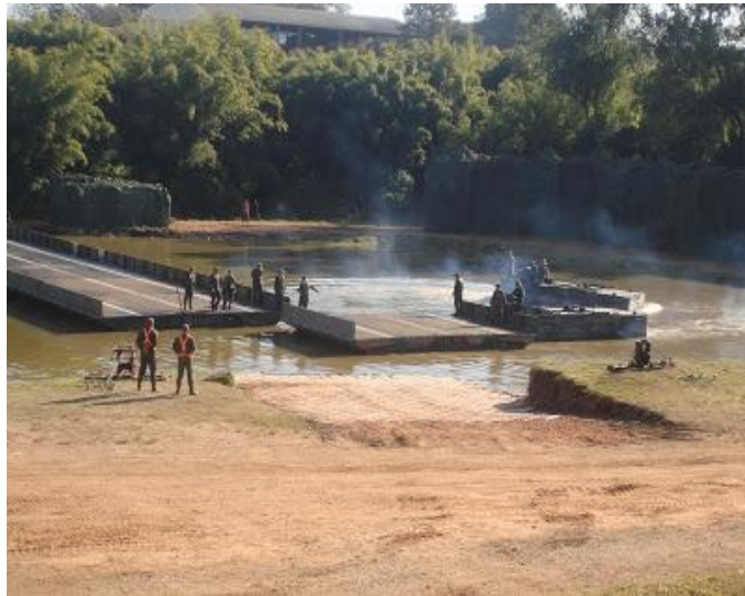
FIGURA 7 – Montagem da Ponte FFB 2000 Krupp
