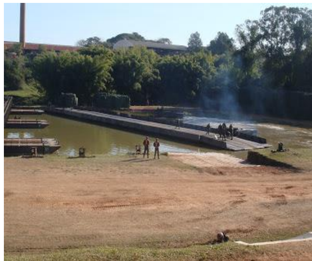
FIGURA 8 – Montagem da Ponte FFB 2000 Krupp
