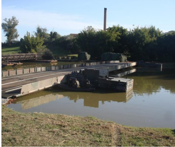
FIGURA 9 – Montagem concluída da Ponte FFB 2000 Krupp
