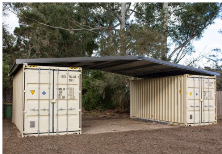
Figura 7 – Cobertura entre contêineres Fonte: Container S/A – 2017.
