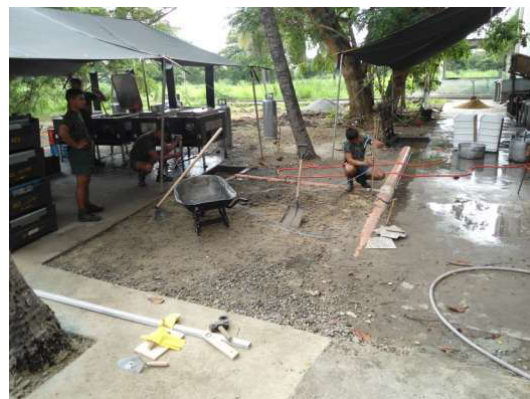
Imagem 27: Colocação de piso de concreto Fonte: Alencar (2015, p. 54)
