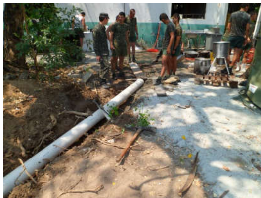
Imagem 15: Mnt da rede de esgoto Fonte: Garbino (2014b, p. 2)
