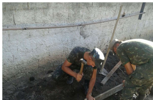
Imagem 33: Construção de pia de lavabo Fonte: 12ª Cia E Cmb L (2016e, p. 5)
