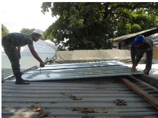
Imagem 26: Construção de telhado Fonte: Alencar (2015, p. 46)
