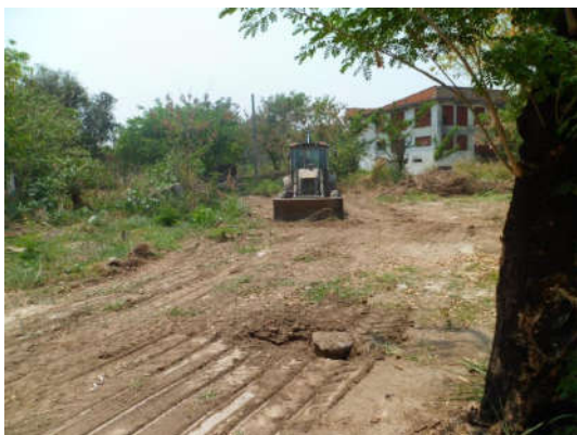
Imagem 14: Construção de Via de acesso Fonte: Garbino (2014b, p. 1)
