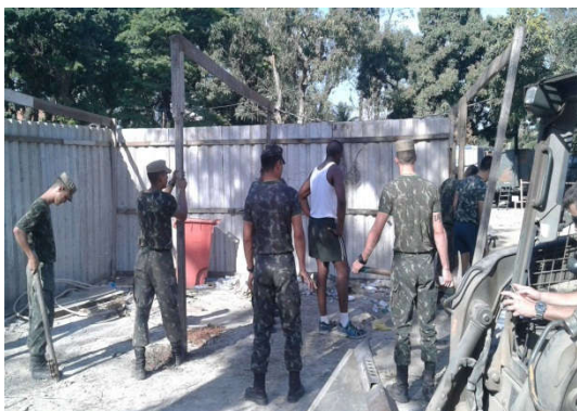
Imagem 34: Desmontagem de barracão Fonte: 12ª Cia E Cmb L (2016g, p. 4)
