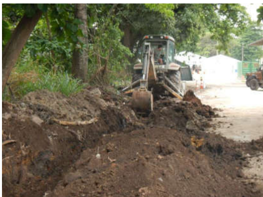
Imagem 17: Construção de valeta Fonte: Garbino (2014c, p. 7)
