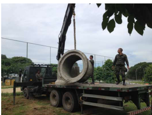
Imagem 22: Transporte de manilha Fonte: Alencar (2015, p. 22)
