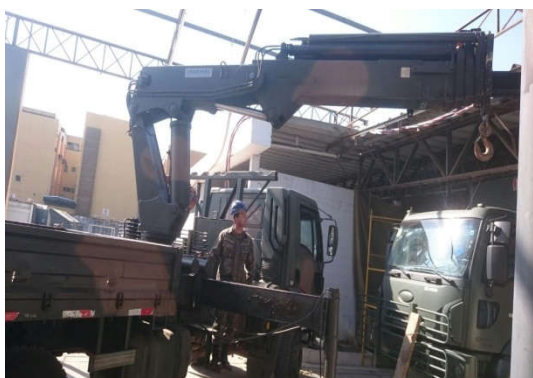
Imagem 36: Reforço de estrutura Fonte: 12ª Cia E Cmb L (2016h, p. 5)
