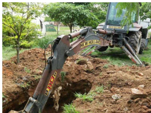
Imagem 19: Construção de caixa de gordura Fonte: Alencar (2015, p. 12)
