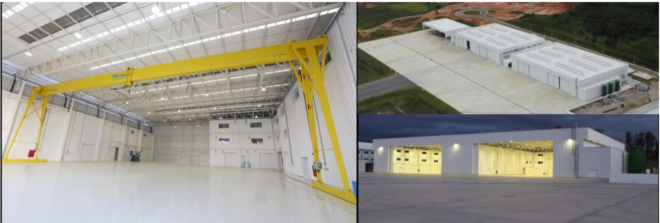
FOTOGRAFIA 2 – Áreas de Manutenção amplas e climatizadas, Paredes isolantes térmicos, Telhados com boa iluminação e Pisos adequados
