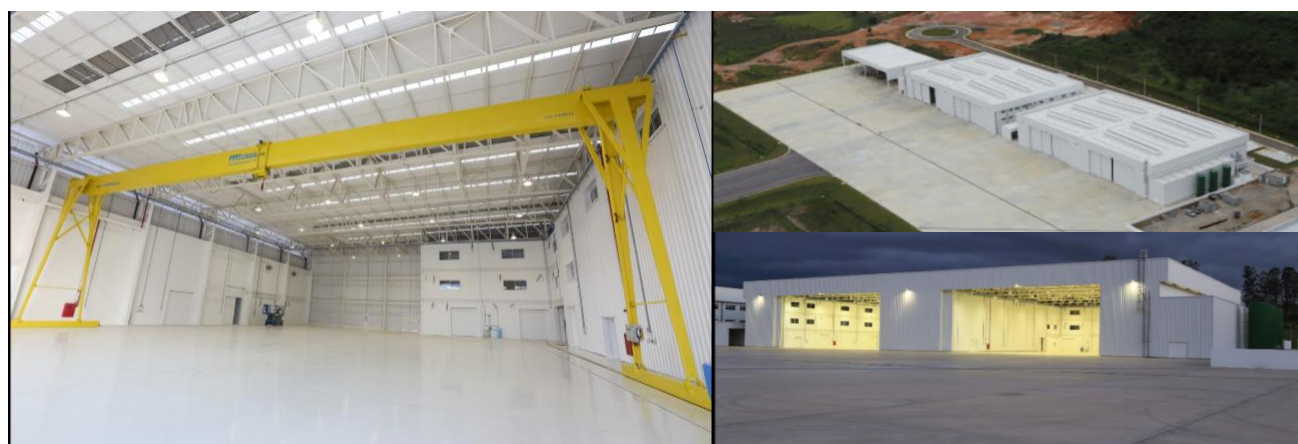
FOTOGRAFIA 2 – Áreas de Manutenção amplas e climatizadas, Paredes isolantes térmicos, Telhados com boa iluminação e Pisos adequados
