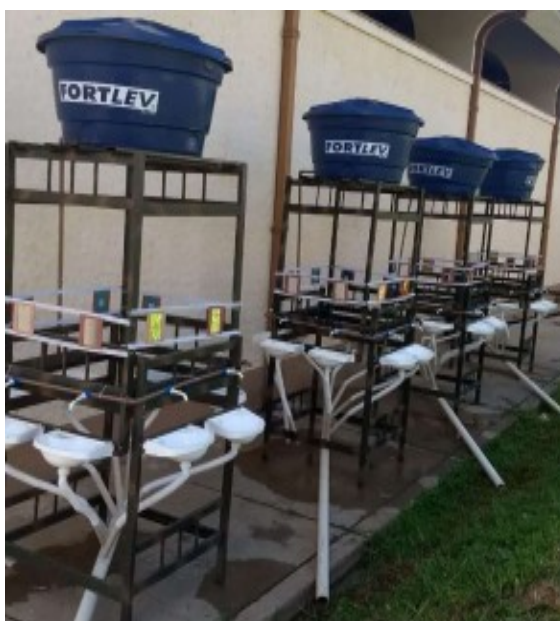
Figura 1: Dispositivo para lavagem de mãos com pia móvel e dispenser para sabão líquido, utilizado em diversos pontos da Manobra Escolar realizada anualmente na AMAN Fonte: Arantes; Prado, 2019.
