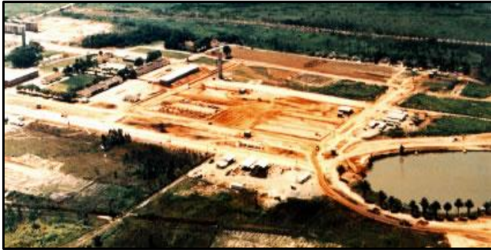
Imagem 2 – Canteiro de obras das novas instalações da AvEx em 1989.
