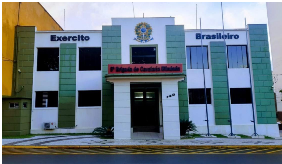
Figura 01 – Instalações do Quartel General da 5ª Bda C Bld, Ponta Grossa-PR.
