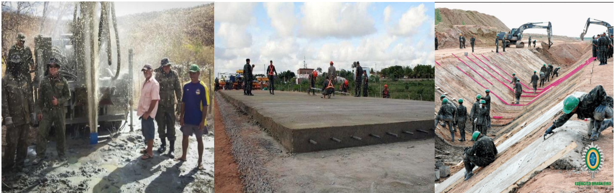
Figura 5 – Perfuração de poço artesiano. Duplicação da Rodovia Federal BR 101. Transposição do Rio São Francisco
