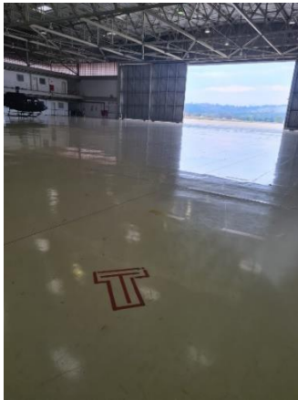
Figura 15 – Marcações no hangar
