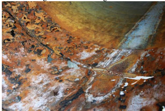
Figura 02: Corrosão galvânica
