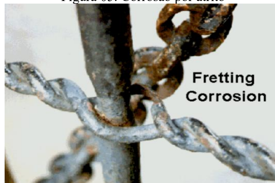
Figura 05: Corrosão por atrito
