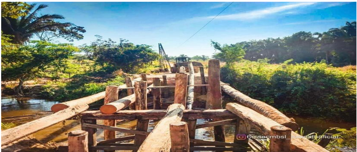
Figura 5 – Reconhecimento e construção de ponte semipermanente na área da 23ª Bda Inf SI
