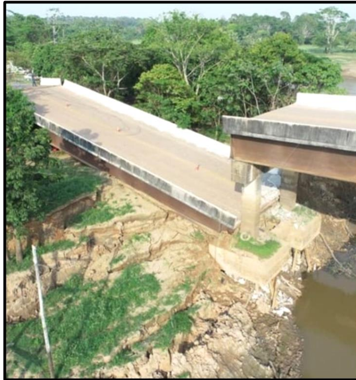
FIGURA 5 – Ponte sobre o Rio Autaz Mirim na BR-319
