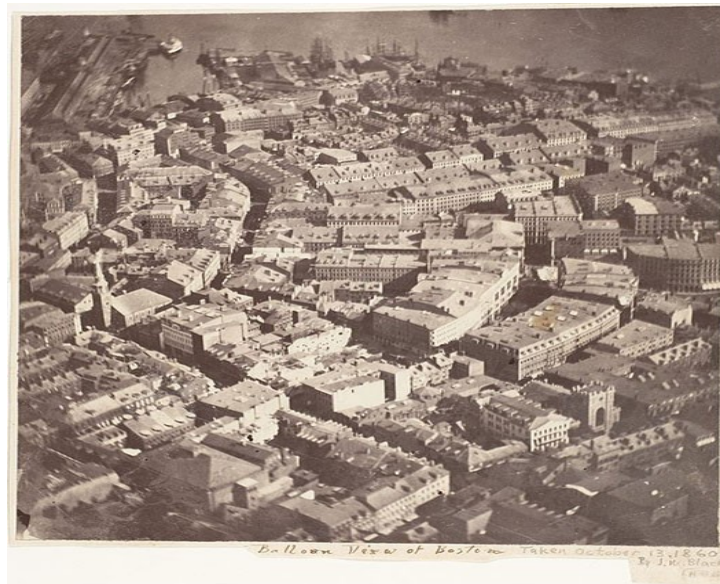
FIGURA 4 - vista de Boston feita em outubro de 1860 por Samuel A. King e James WBlack
