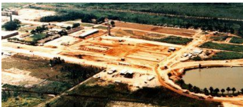
Figura 7 — Canteiro de obras das novas instalações, foto de fevereiro de 1989
