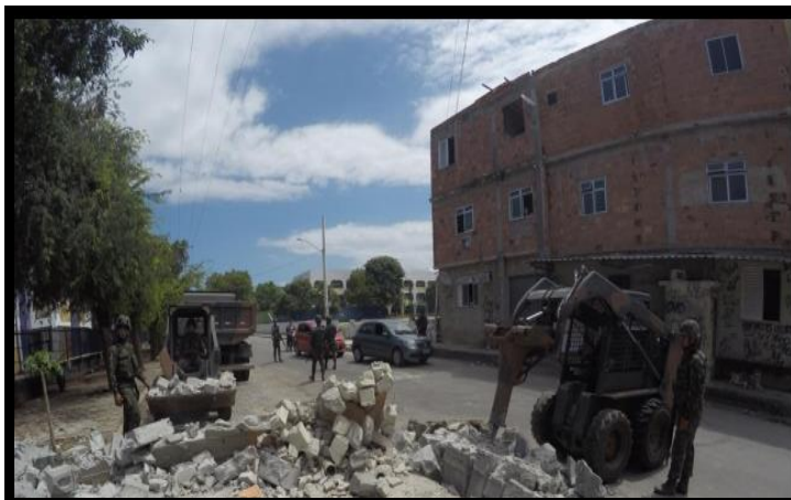
Figura 04 – Militares de engenharia utilizando equipamentos de Engenharia
