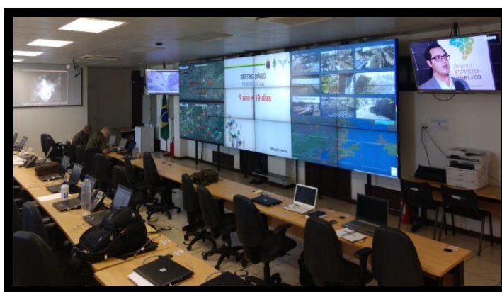
Figura 01: Sala de operações do Centro de Coordenação de Operações (CCOp) do CCj
