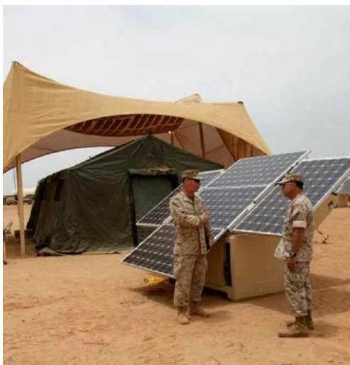
Figura 3: Gerador DS-STAL7520 Fonte: DEPAR SOLAR, 2023
