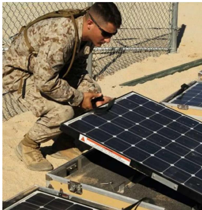
Figura 4: Gerador DS-STAL9100-MIL Fonte: DEPAR SOLAR, 2023
