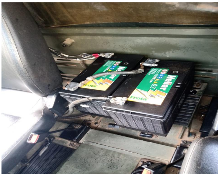
1- Cj de baterias complementar Vtr Marruá
