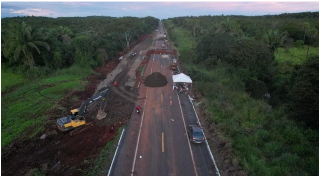
Figura 11: BR-226 interditada após pista se romper por conta das condições climáticas
