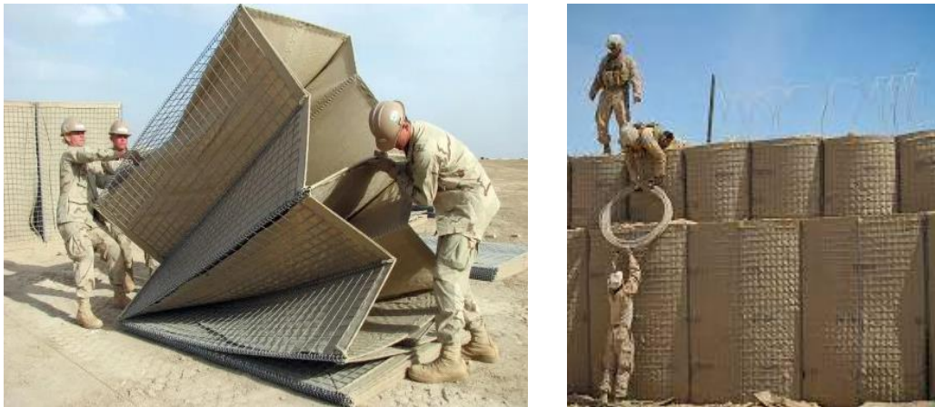
Figura 11 e 12: Militares realizando a montagem dos sacos especiais de areia e colocação de concertinas.
