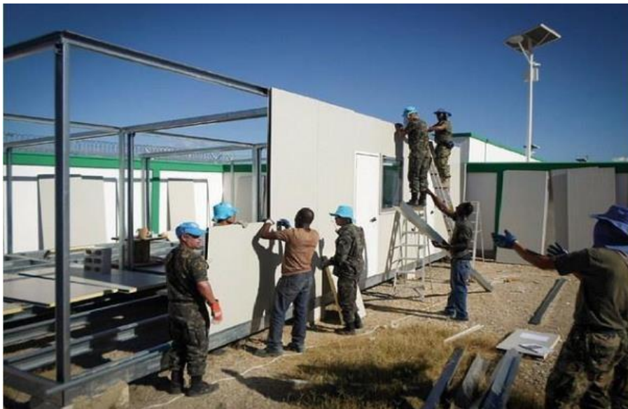
Figura 3 – Construção de infraestrutura da base
