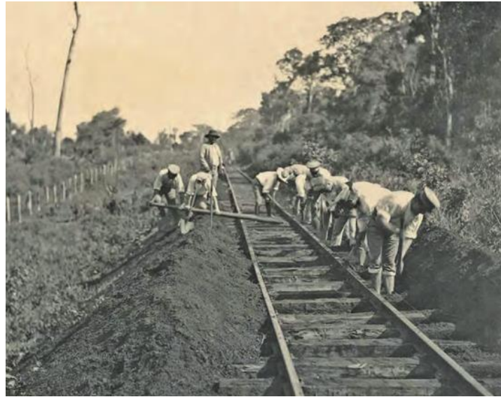
Figura 15- Militares realizando trabalhos de regularização de linha
