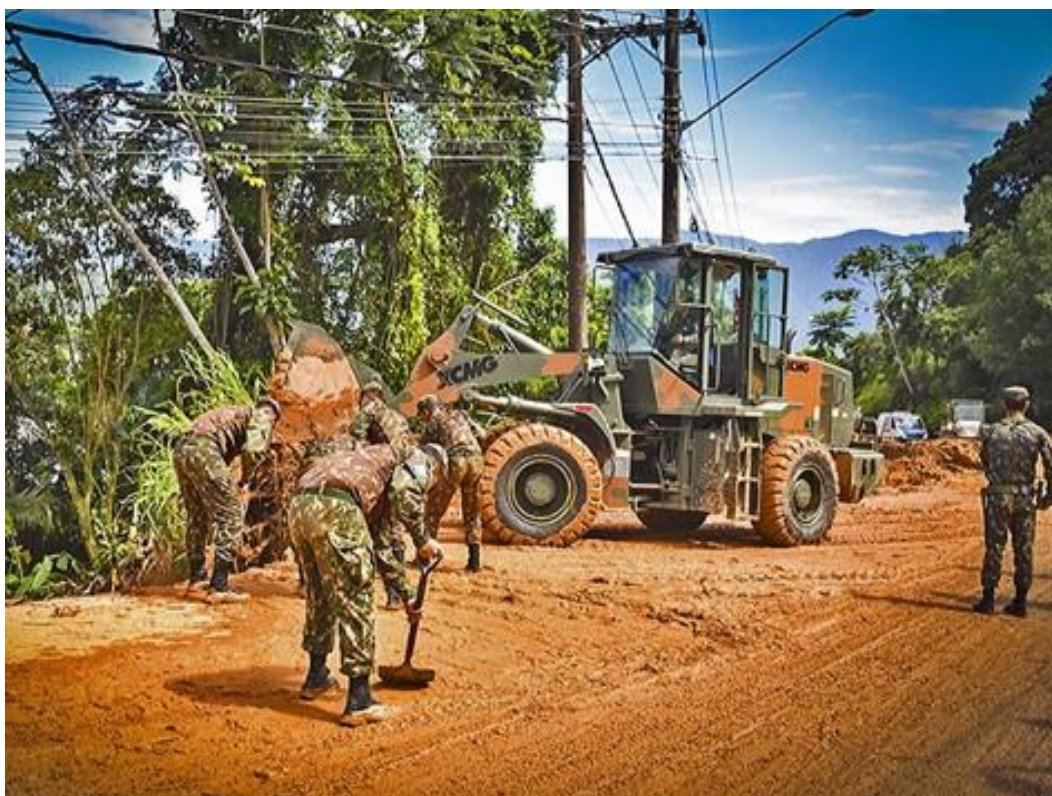
Figura 6 - Engenharia atuando na desobstrução de pontos da Rodovia Rio-Santos (BR-101)
