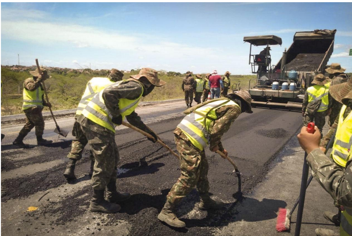
Figura 03 – Engenharia do Exército trabalha para ampliar trafegabilidade na BR-226 / RN
