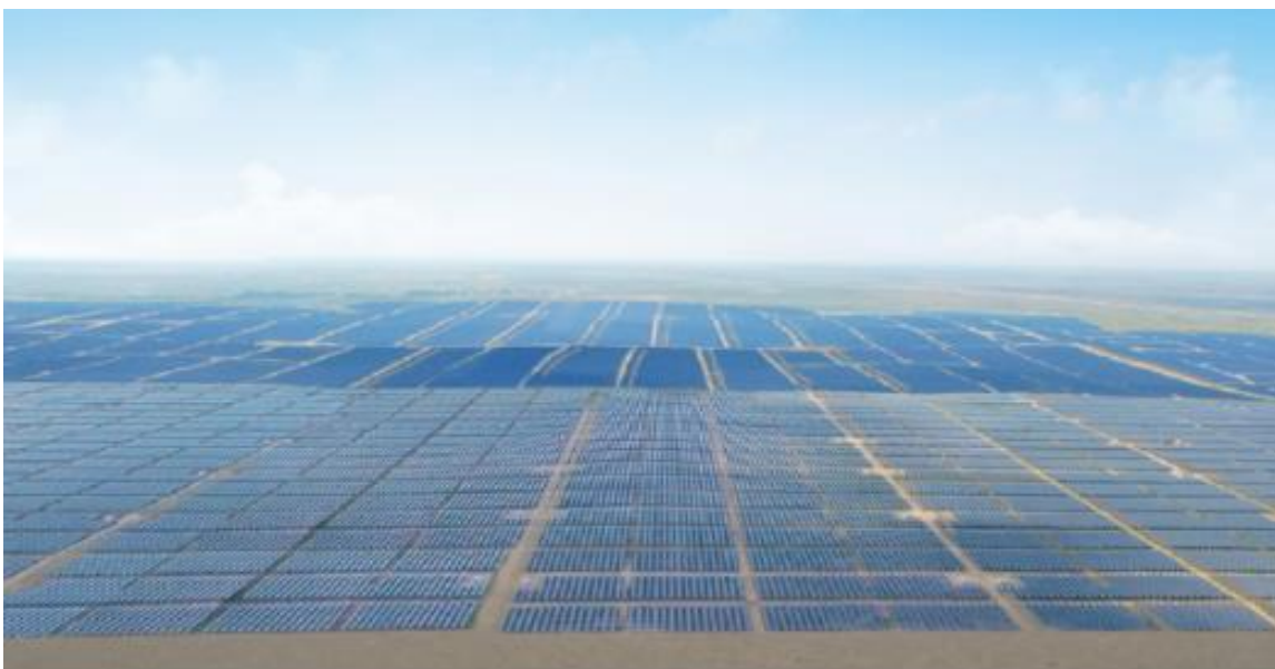
Figura 6 – Usina fotovoltaica de Yanchi – China
