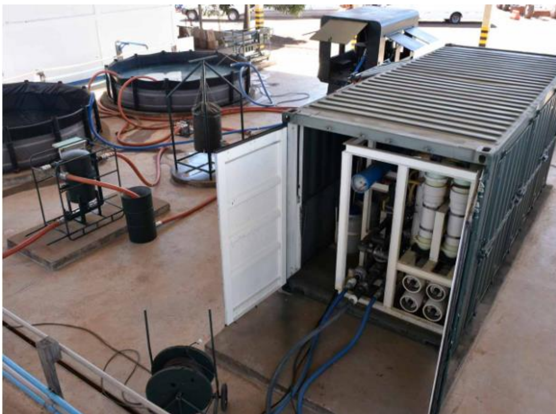
FIGURA 6- Estação de Osmose Reversa do 2º B Fv Fonte: Sítio eletrônico do 2º B Fv
