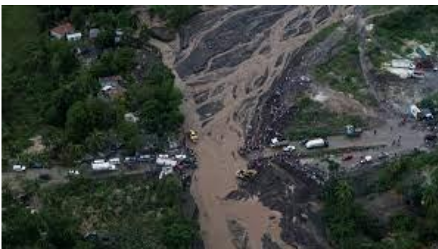
FIGURA 17- Estrada interditada após passagem do Furacão Mathew Fonte: Sítio eletrônico da ONU
