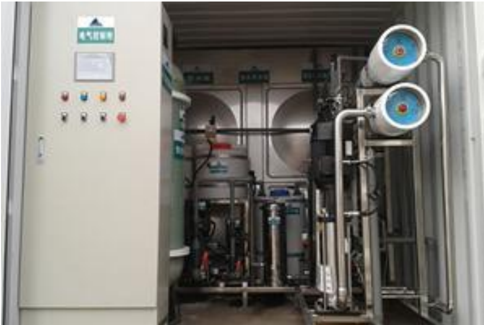
FIGURA 31- Equipamento de osmose reversa embarcado da empresa QUNFENG Fonte: Sítio eletrônico da empresa QUNFENG
