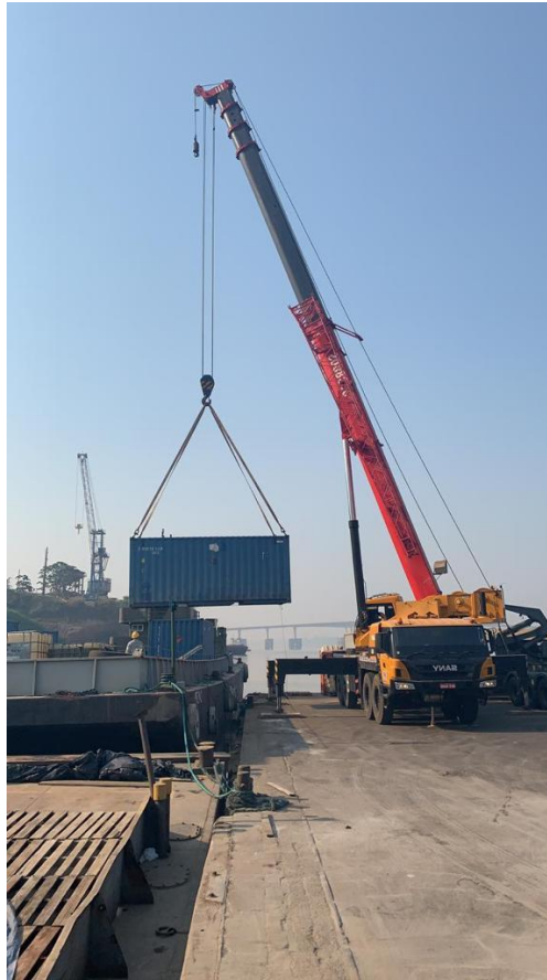
Figura 4 - Guindaste capacidade de 45 ton Operando no Porto de Porto Velho – RO
