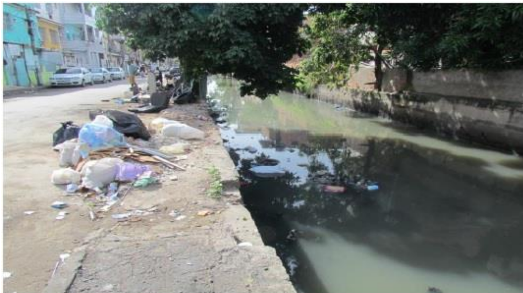
Figura 17 – Obstáculos fluviais no interior da Favela na Maré Fonte: Souza (2019)
