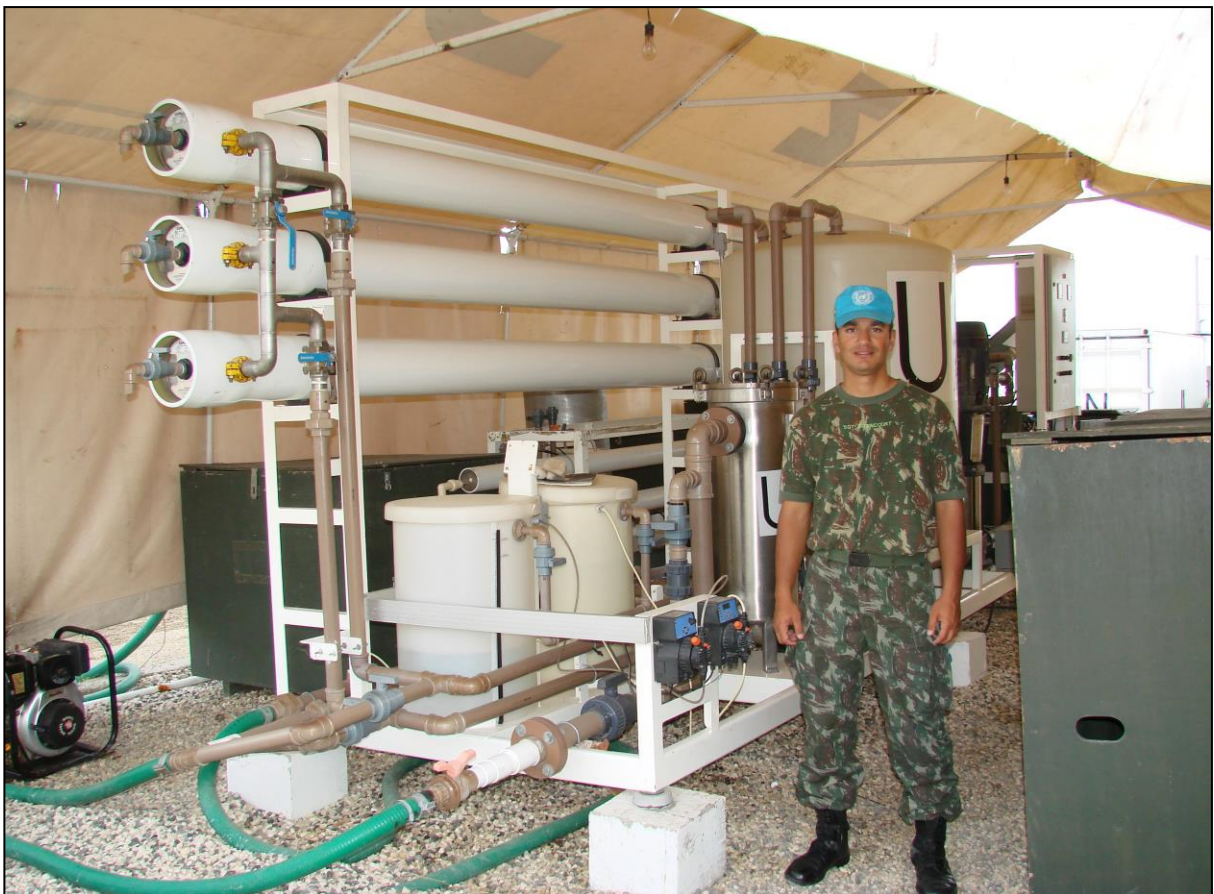
Figura 1: Equipamento de Osmose Reversa utilizado pelas tropas de missão da paz, no Haiti Fonte: o autor, através de um militar que já esteve em Missão de Paz no Haiti.
