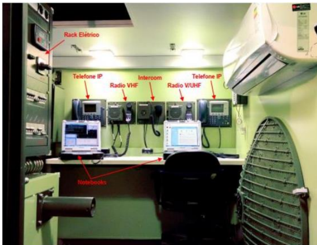
FIGURA 10 – Vista Geral Interna do MTO
