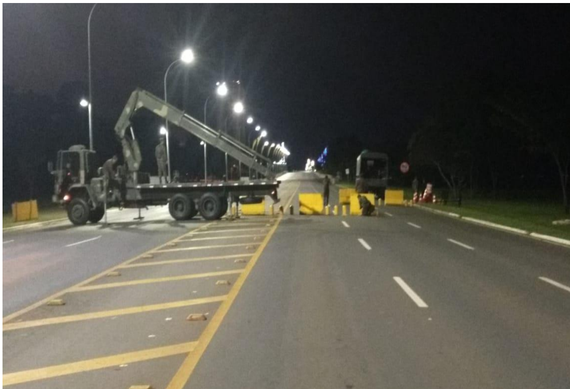
Fig 14 – Interdição de vias com barreiras “New Jersey” em Brasília/Op. Posse Fonte: Relatório de Operações/3ª Seção da 23ª Cia E Cmb, 2019.
