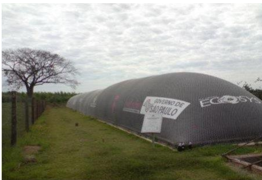
Figura 13 – Biodigestor Modelo Canadense
