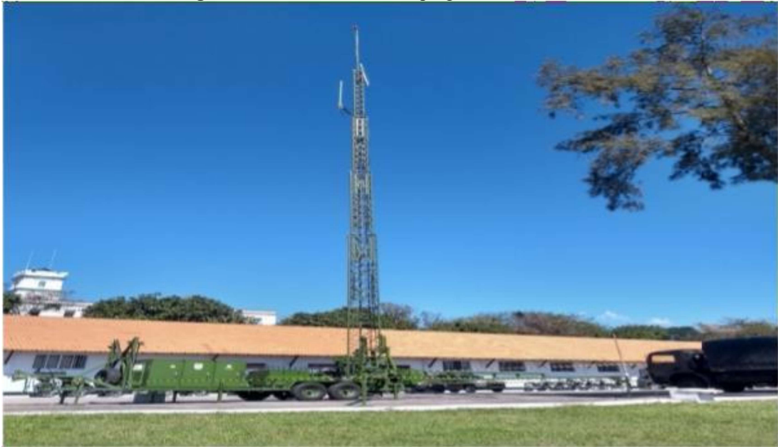
Figura 1: Site Móvel sendo empregado no ano de 2018.
