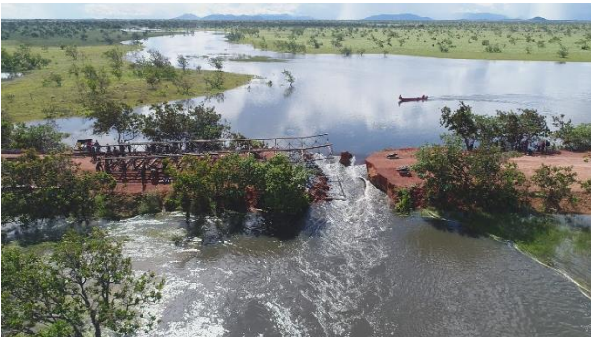
Imagem 2 - Construção de ponte de equipagem tipo Bailey, pelo 6º BEC, sobre bueiro rompido na BR-401/RR, Terra Indígena Raposa Serra do Sol, município de Normandia-RR.
