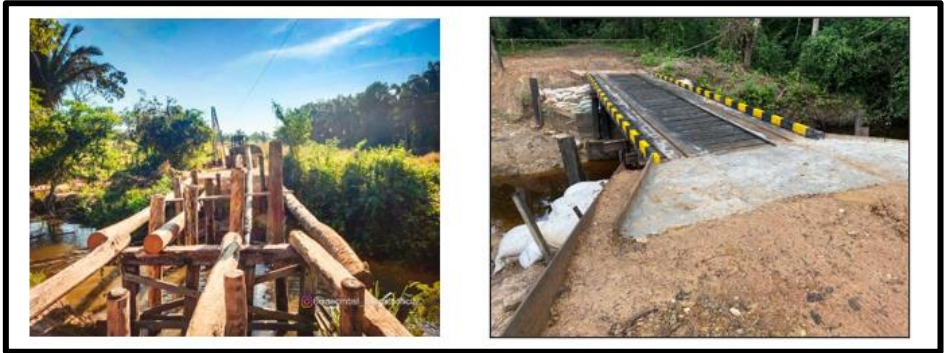
Fig 6-4 – Ponte construída em área de selva
