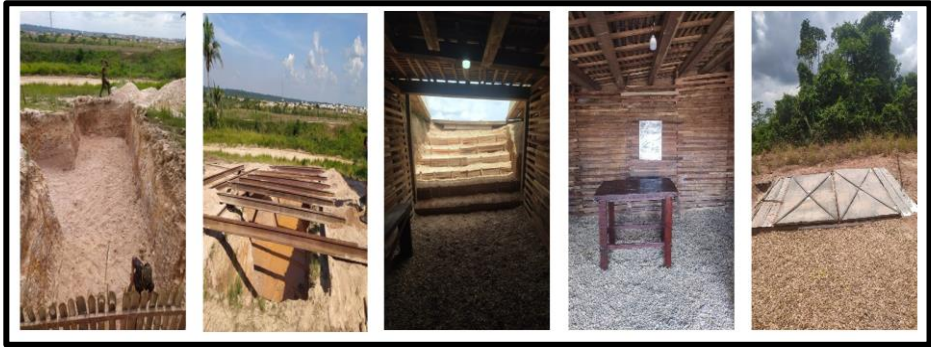
Fig 6-6 – Sequência da construção de PC enterrado
