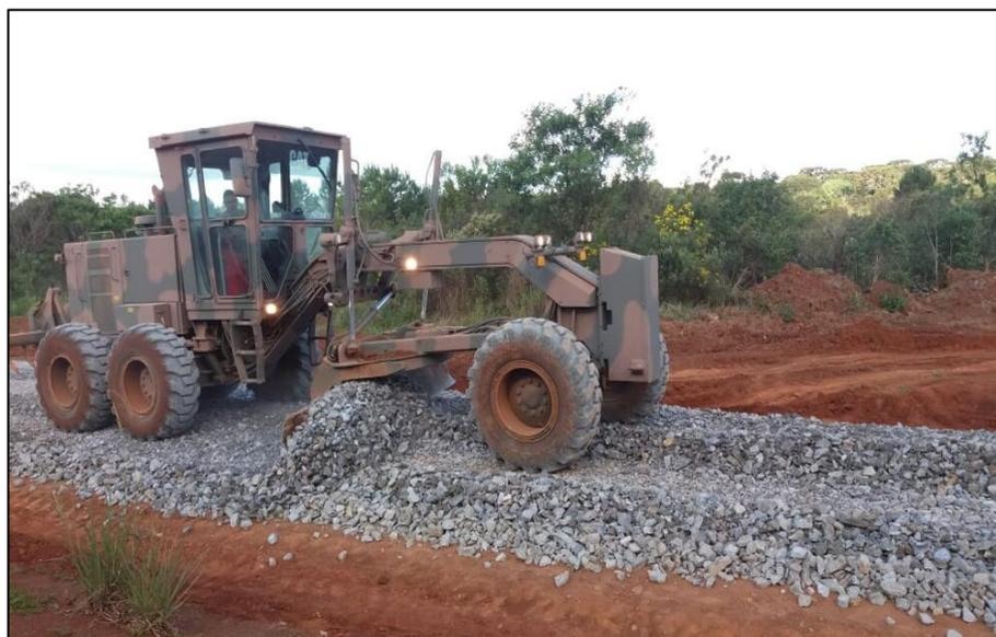
FIGURA 12 – Obras de pavimentação no CIMH (Três Barras/SC)
