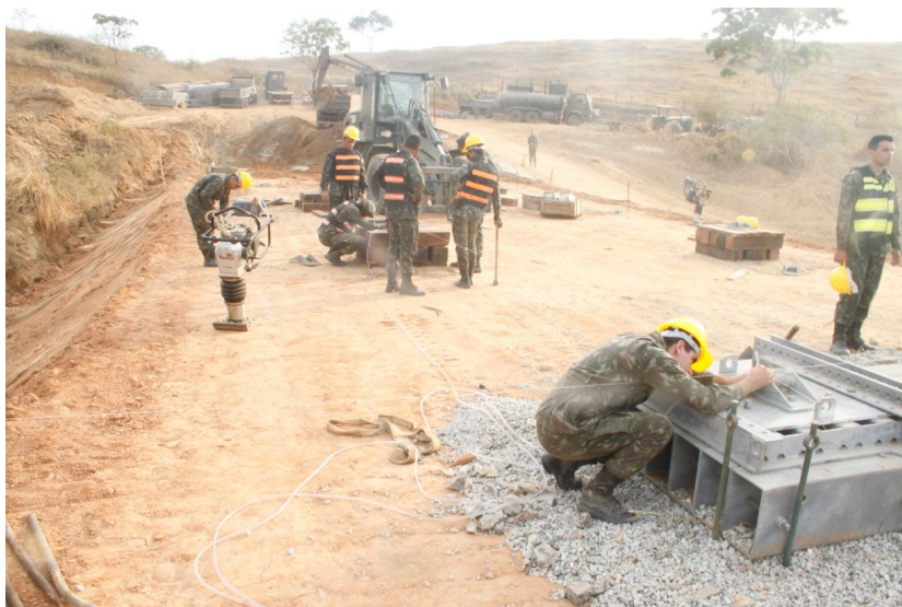
FIGURA 10 – Montagem da Ponte LSB em Jacinto-MG Fonte: 23ª Cia E Cmb (2015).
