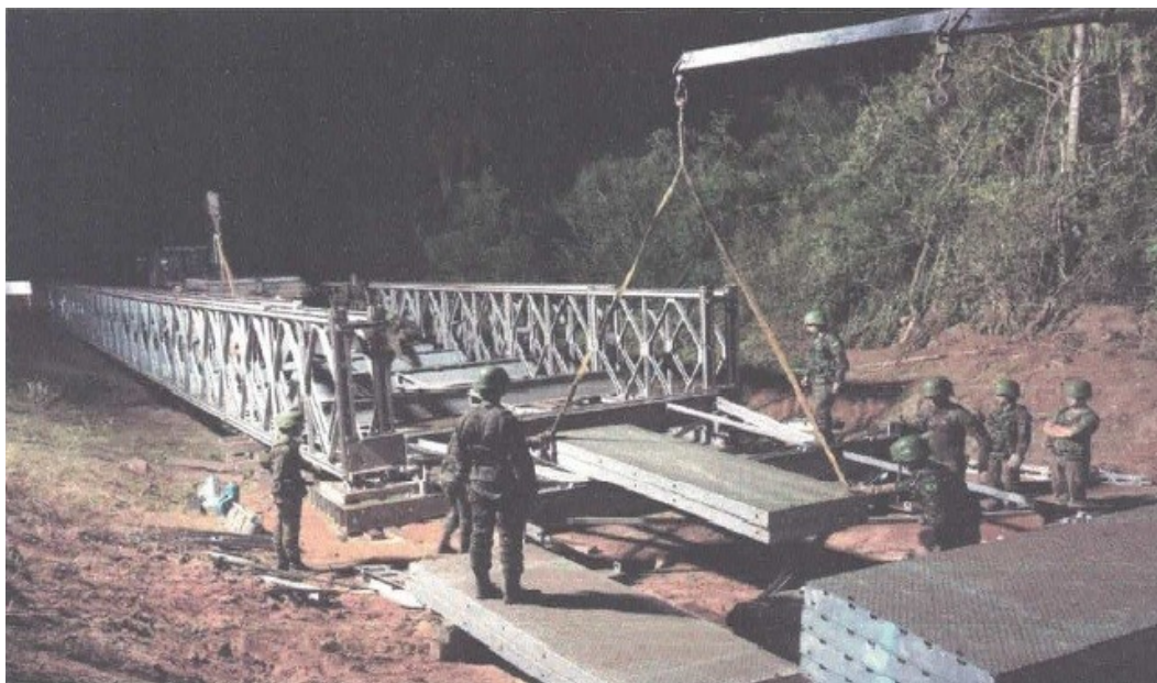
FIGURA 11 – Adestramento noturno de montagem da Ponte LSB na Operação Relâmpago. Fonte: 3º BE Cmb (2021).
