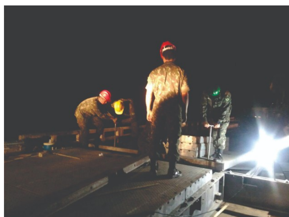
FIGURA 3 – Montagem noturna da Ponte LSB do 2º BEC e tráfego da BR-402 Fonte: 2º BEC (2017)
