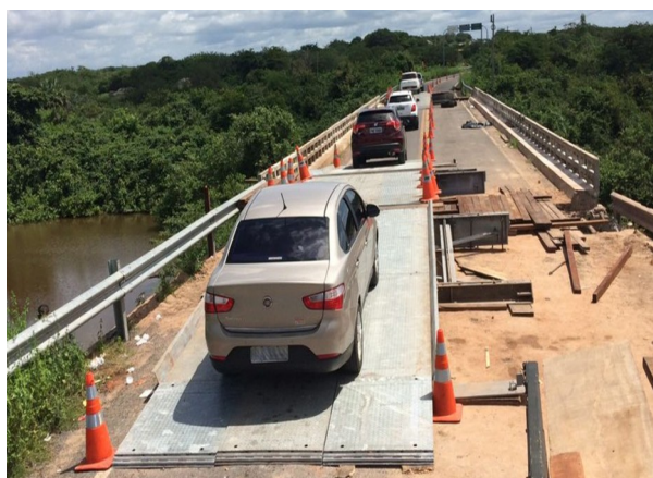
FIGURA 3 – Montagem noturna da Ponte LSB do 2º BEC e tráfego da BR-402 Fonte: 2º BEC (2017)
