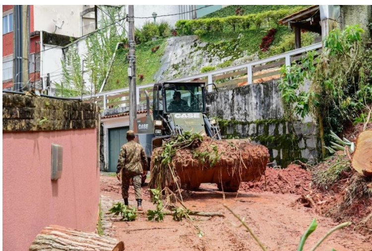
FIGURA 2 – Engenharia do EB desobstruindo ruas de Petrópolis. Fonte: Defesa em foco (2022).
