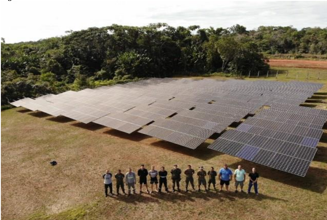
Figura 9: Painéis fotovoltaicos 7º PEF Tunuí
