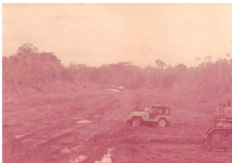
Figura 2: Início das obras da BR-174.
