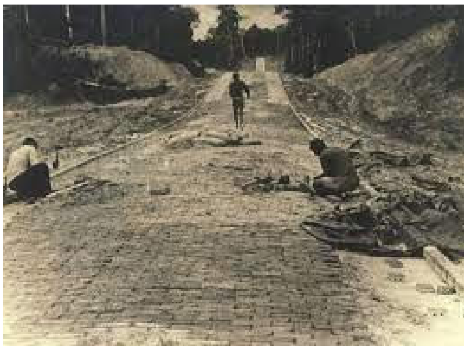
Figura 03 - Pavimentação de estrada no Estirão do Equador (década 70) acervo 7º BEC.
