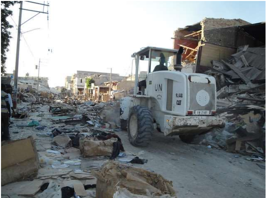
Figura 5 – BRAENGCOY desobstruindo as ruas de Porto Príncipe, Jan 2010.
