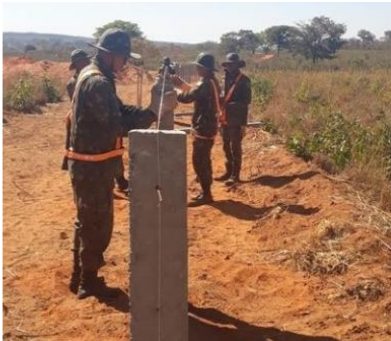
Figura 9 – Colocação dos moirões de cerca
