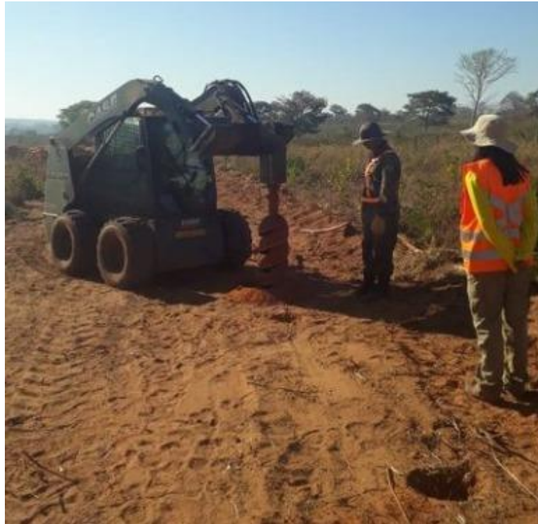
Figura 8 – Equipe de cercamento perfurando o solo
