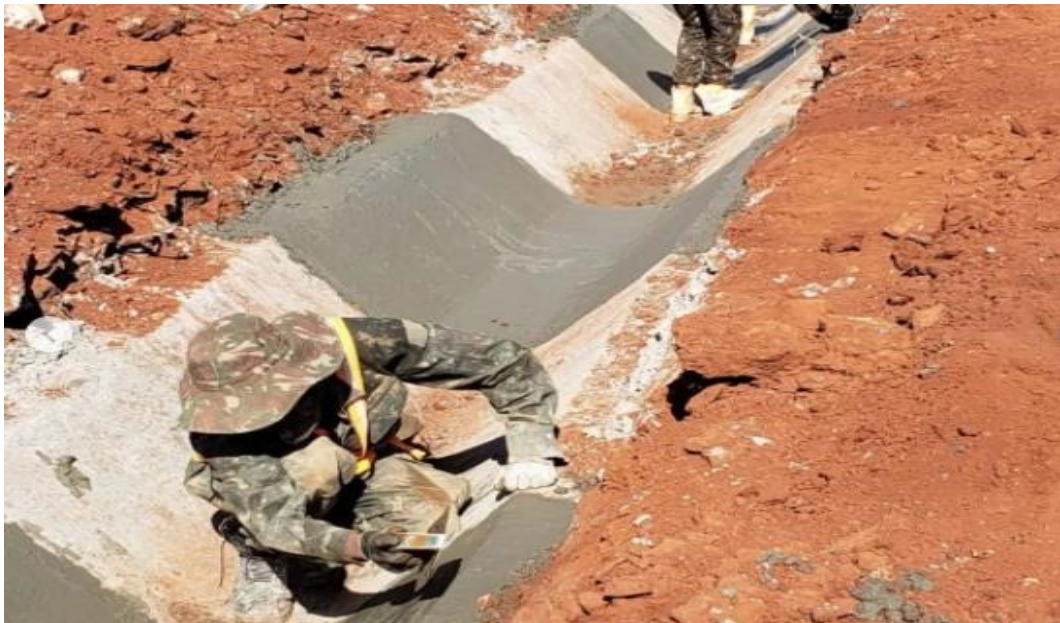
Figura 5 – Valeta de drenagem
