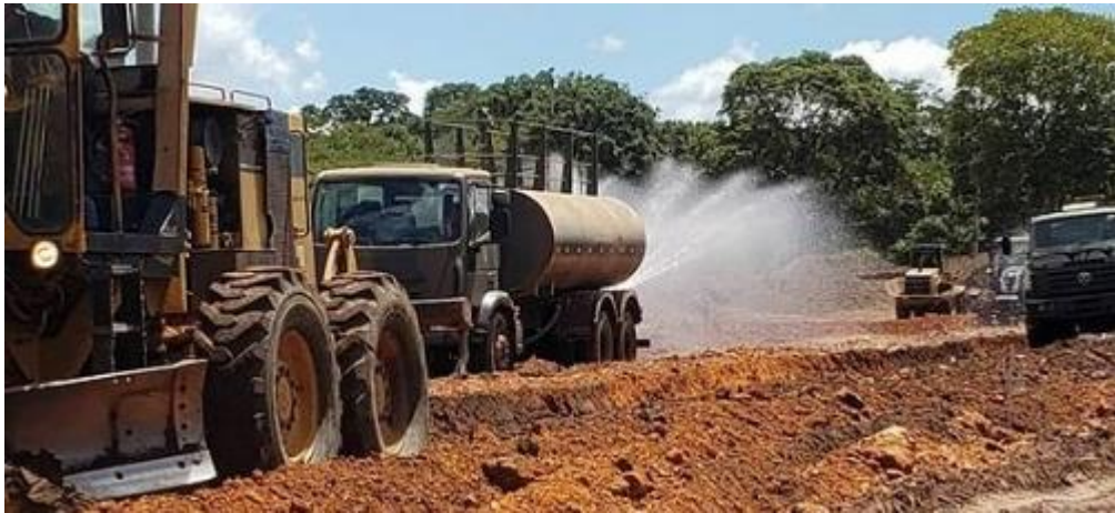
Figura 3 –Terraplanagem com uso de caminhão transportador de água
