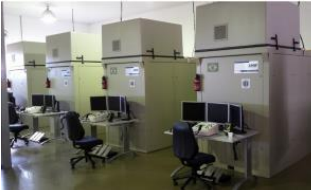
Figura 9 – Cabines de operação do TSB
