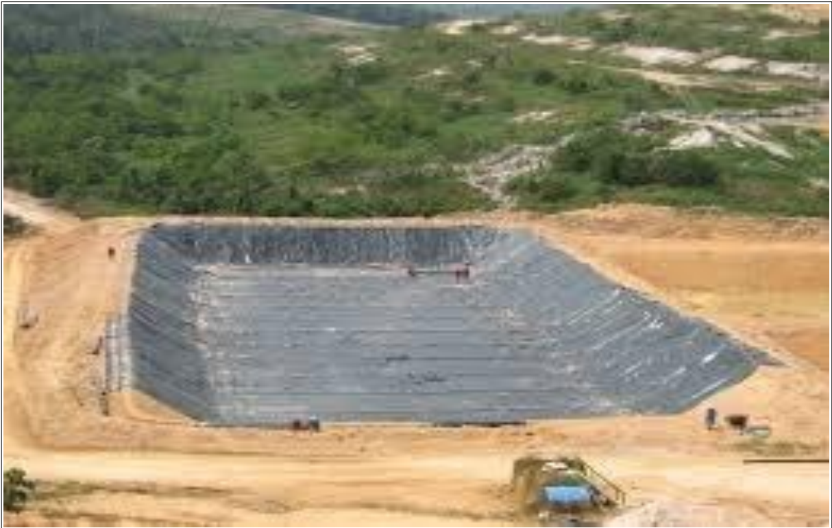
Figura 10 – Construção de aterro sanitário
