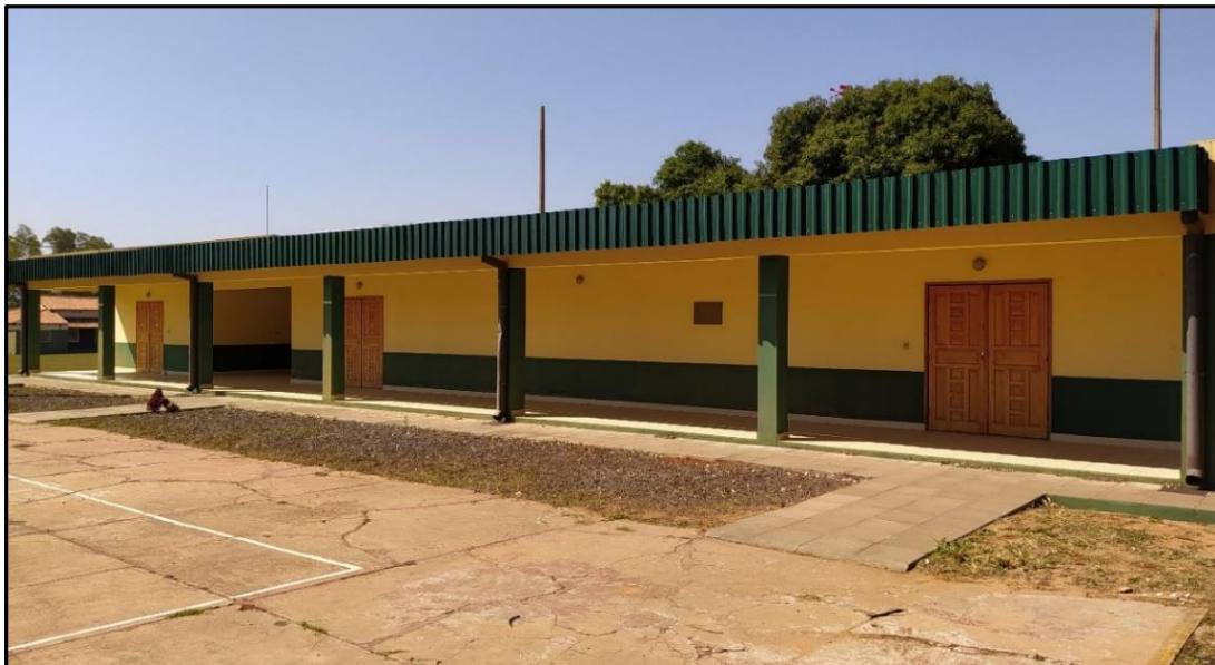
Figura 2 – Frente do prédio do simulador de tiro no RC4 Fonte: O autor
