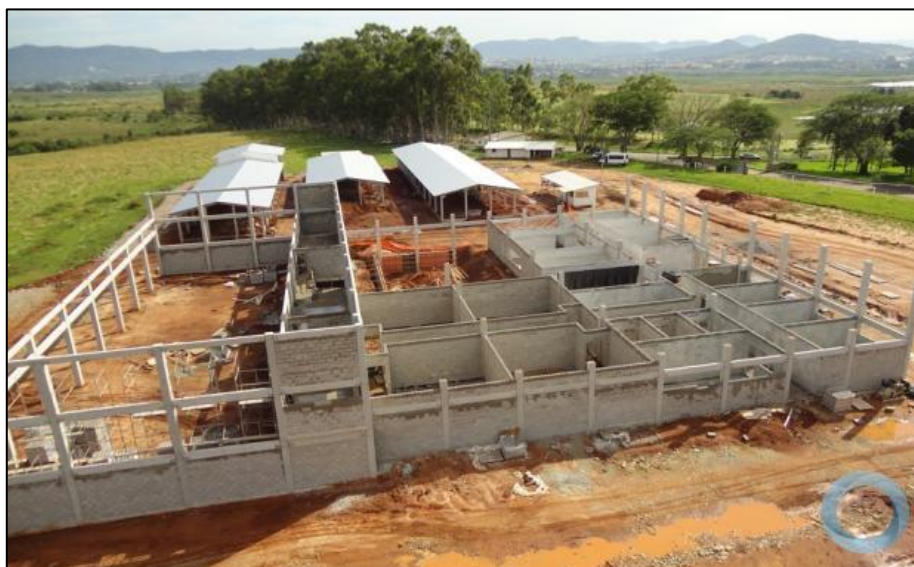
FIGURA 12 – Pavilhões do SIMAF em construção
