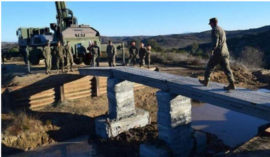
Figura 2 – Ponte de concreto do Exército dos EUA fabricada em impressora 3D
