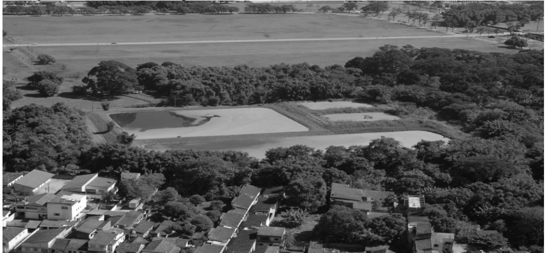
Figura 8 - Estação de tratamento de água
