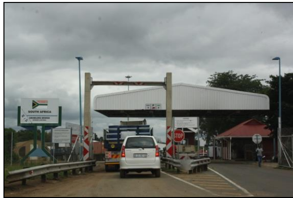
Figura 6: posto de controle de fronteira de Grobler's Bridge, na fronteira com Botsuana
