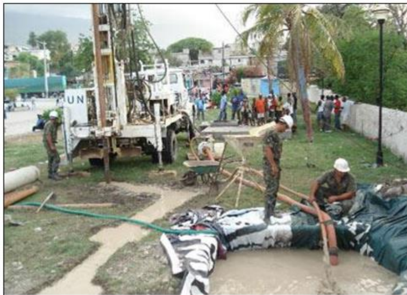
Figura 05 - BRAENGCOY realiza perfuração de poço para comunidade em Porto Príncipe Fonte: MACHADO, 2009, p.74
