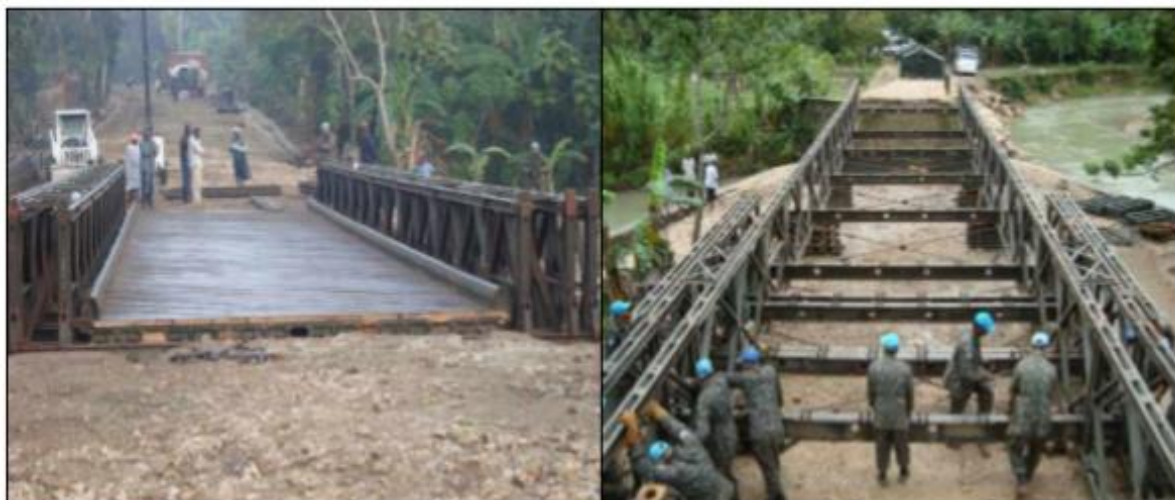
Figura 06 - Ponte de equipagem, lançada pela BRAENGCOY, para restabelecer o trânsito no Norte do Haiti Fonte: MACHADO, 2009, p.76
